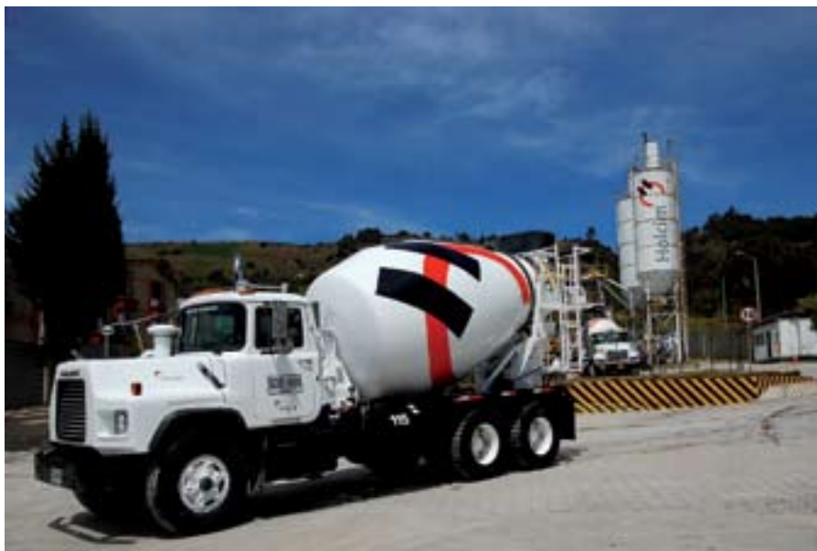
Planta de concreto de Tunja
