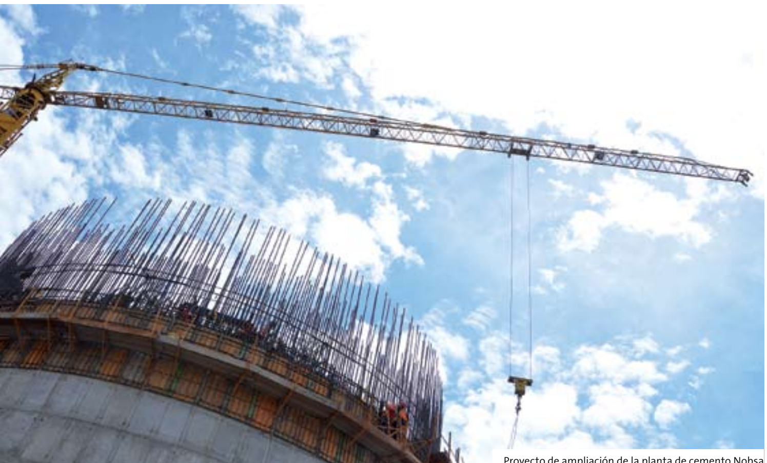
Proyecto de ampliación de la planta de cemento Nobsa
