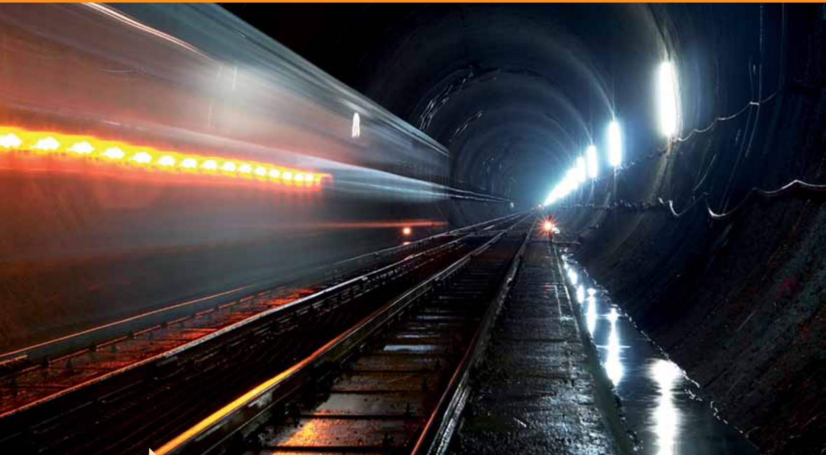
Proyecto NEAT, el túnel ferroviario más largo del mundo, construido en Suiza.
