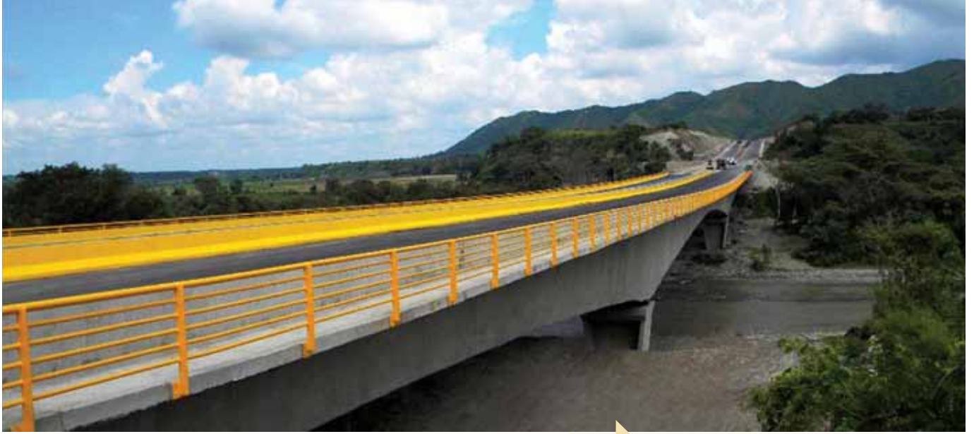
Puentes sobre el río Coello en la vía Girardot-Ibagué
