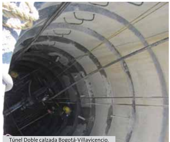
Túnel Doble calzada Bogotá-Villavicencio.
