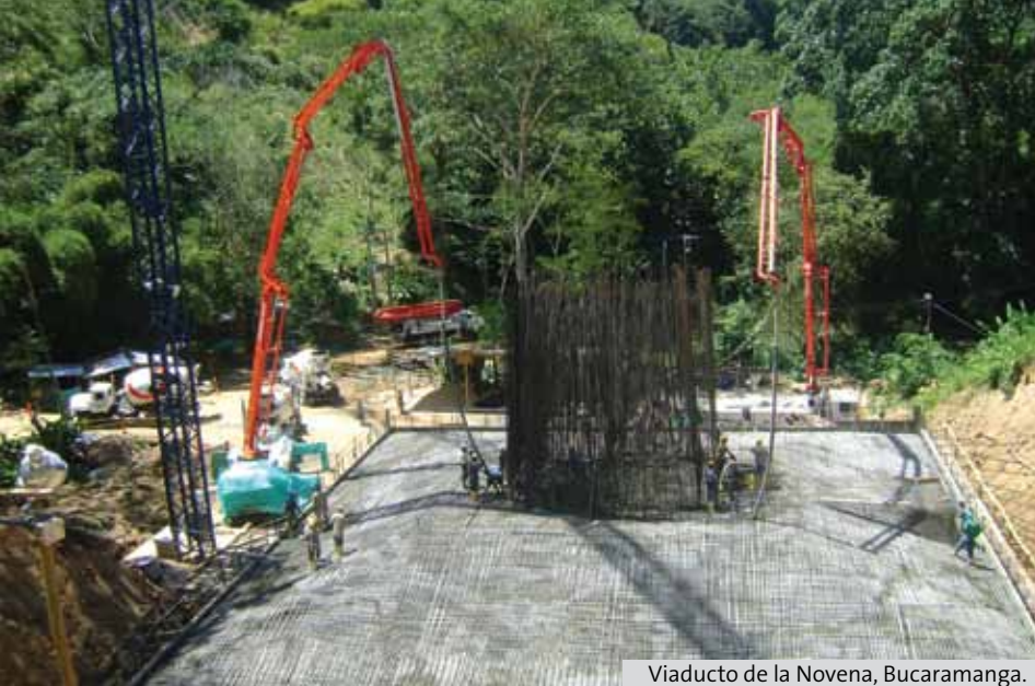
Viaducto de la Novena, Bucaramanga.
