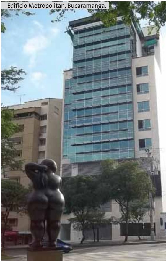
Edificio Metropolitan, Bucaramanga.
