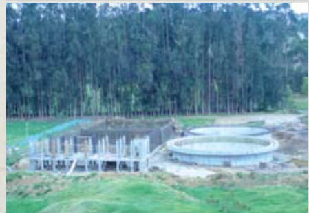
Obra: Planta de tratamiento de aguas residuales
