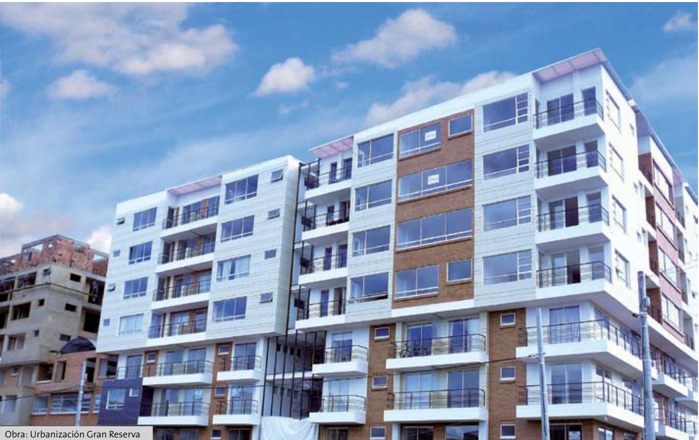
Obra: Urbanización Gran Reserva
